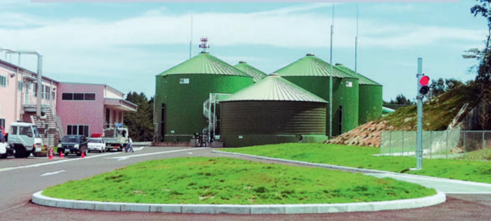
Eine Biogasanlage der Firma Lipp GmbH Anlagenbau und Umwelttechnik aus Thannhausen in Sendai, Japan. Leistung: 244 kW elektrisch, 260 kW thermisch. Gesamtinput pro Jahr: rund 60.000 Tonnen Lebensmittelabfälle und organischer Schlamm.
